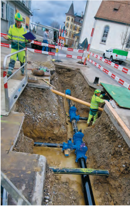
Bei der Ebnaterstrasse wurde zwischen der Barriere und der Untersandstrasse die Wasser-Hauptleitung mit 200 mm Durchmesser ersetzt, inkl. allen Seitenanschlüssen. Diese Leitung ist ein Teil der durchgehenden 200 mm-Leitung zwischen den beiden Reservoiren Nestenberg und Bergli.
